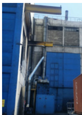
セメントハウス（ゴム揮：有機溶剤）の排気口の改善
