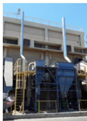
化学物質使用機器の排気口の改善
