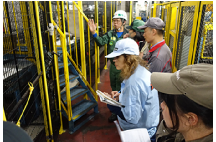
設備の安全対策などを見学
