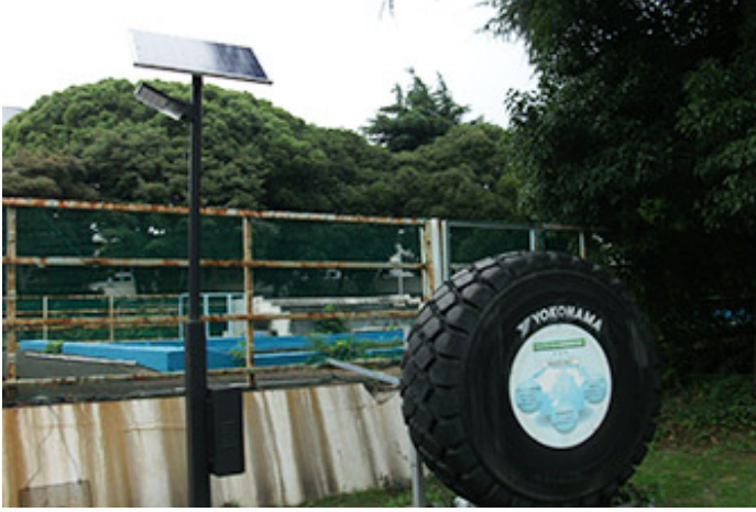
ソーラー街路灯の設置
