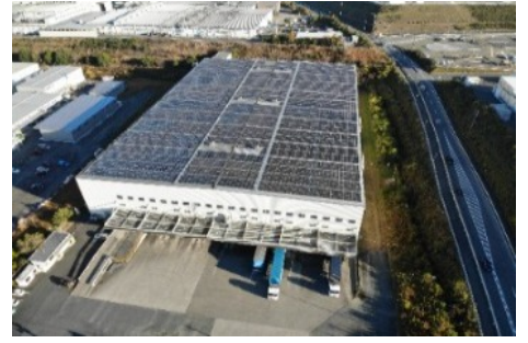
太陽光発電（新城南） 設備容量：1,040kw
