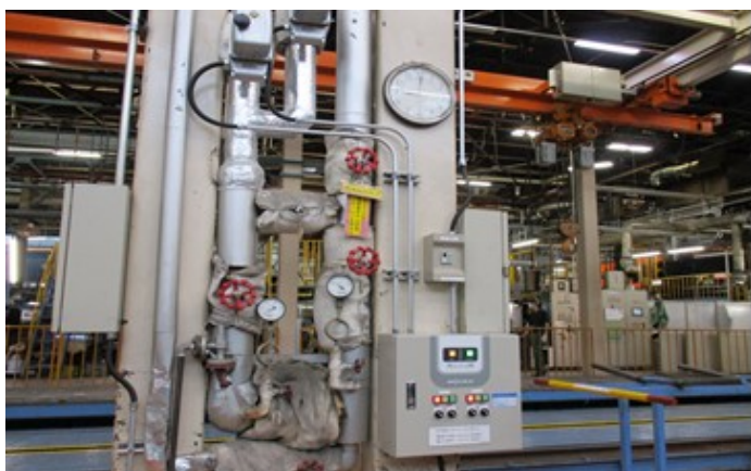
【蒸気系統を分離しモーター弁取付】
