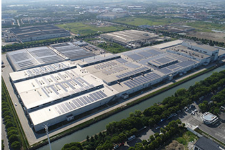
太陽光発電（中国：蘇州） 設備容量：3,000kw
