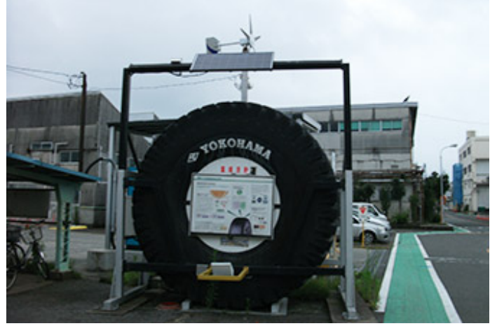
ソーラー+風力利用街路灯の設置
