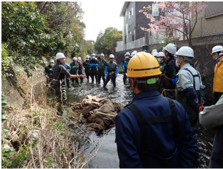
河川管轄協働での「バープ工」施工の様子
