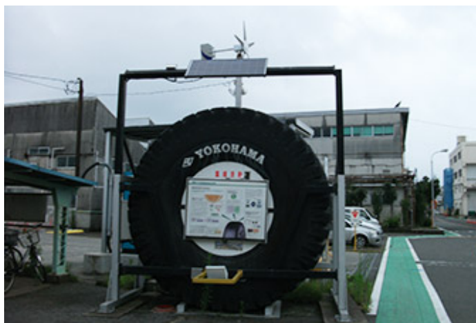
ソーラー+風力利用街路灯の設置
