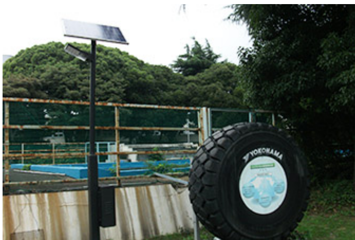
ソーラー街路灯の設置
