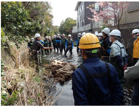
河川管轄協働での「バープ工」施工の様子
