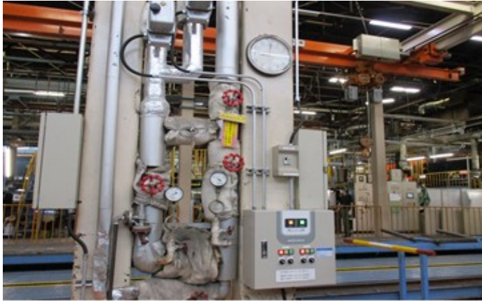
【蒸気系統を分離しモーター弁取付】
