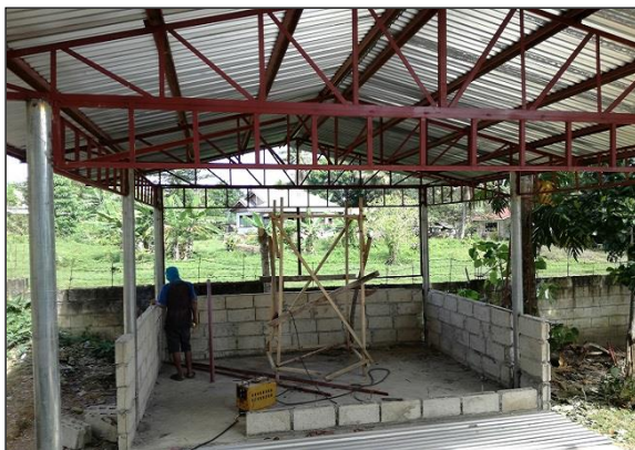
建設中のMRF
