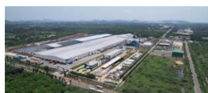
インド・ヴィシャカパトナム工場（左側が建設中建屋）
